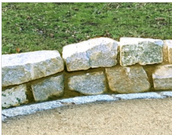
Mauer mit Mörtel
